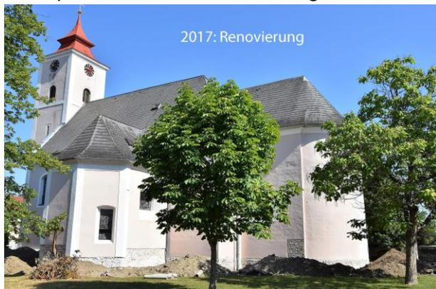
Die Arbeiten werden durch die Fa. Leitzinger aus Michelhausen und die Fa. Haubenberger aus Oberegging durchgeführt. Die Grundfeste der Kirche wurde mit einem wasserdichten Anstrich versehen, danach wurde die Sohle
